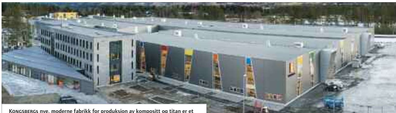
KONGSBERGS nye, moderne fabrikk for produksjon av kompositt og titan er et av de største industribyggene som er reist i Norge de seneste årene.
